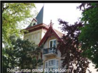
Restauratie pand te Apeldoorn
