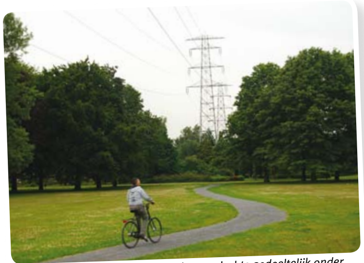
De hoogspanningskabels in Zuid gaan slechts gedeeltelijk onder de grond. Foto: GtV
