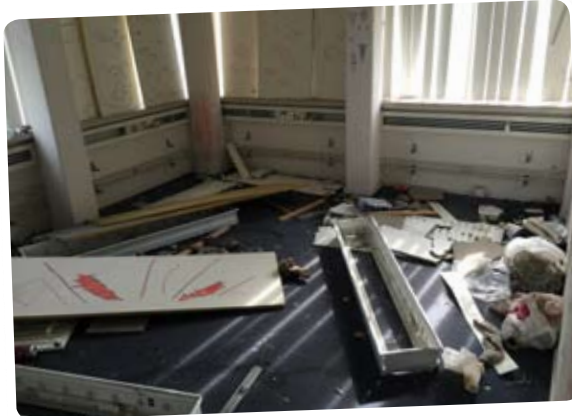
In het Westpointgebouw is het een grote bende. Er is van alles gesloopt en er ligt afval van zwervers en anderen die illegaal in het leegstaande kantoor bivakkeren.
