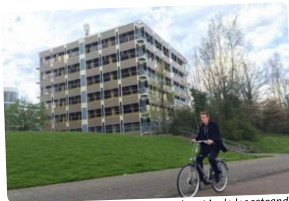
De noodopvang voor vluchtelingen komt in de leegstaande UWV-kantoren Foto: GTV
