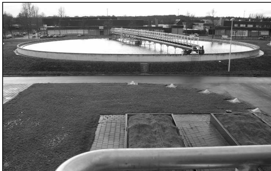
De zuiveringsinstallatie in Apeldoorn-Noord.
