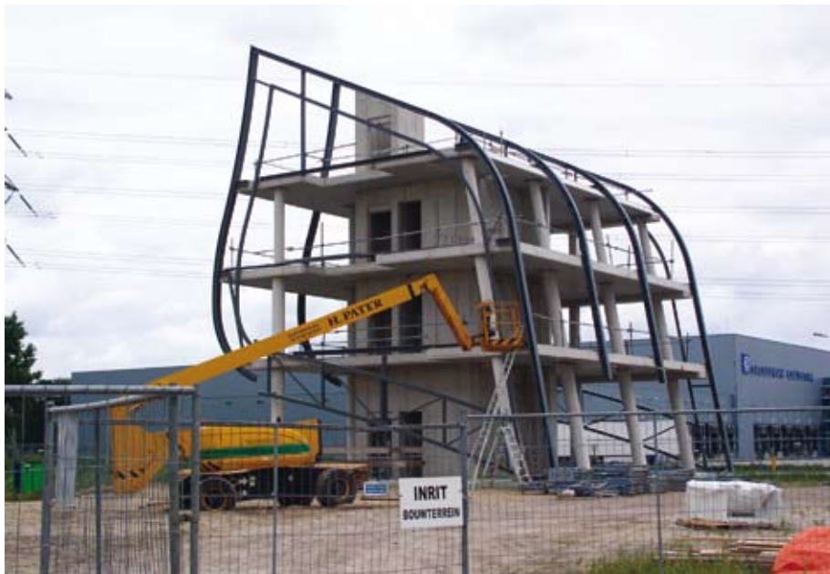
De uitgifte van bedrijventerreinen gaat moeizaam. Ook de Ecofactorij is nog niet vol. Hier wordt het Infocentrum in de vorm van het logo van de gemeente gebouwd (foto).
