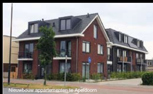
Nieuwbouw appartementen te Apeldoorn
